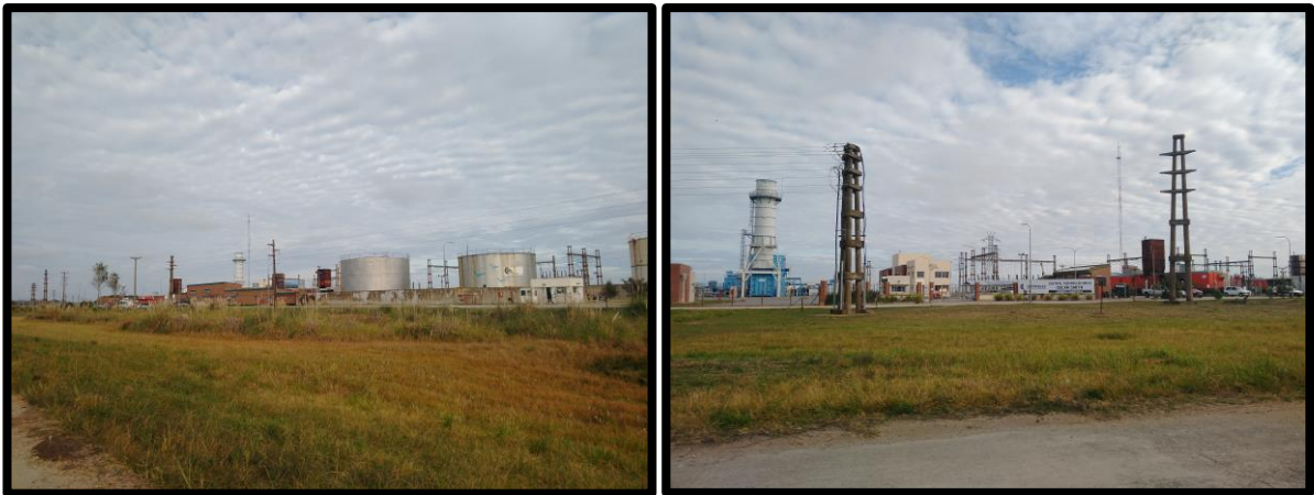
Figura 93 – Central termoeléctrica Oscar Smith. General Madariaga.
