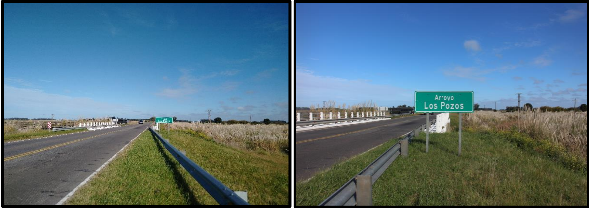
Figura 141 - Arroyo Los Pozos, altura PR 30+500.
