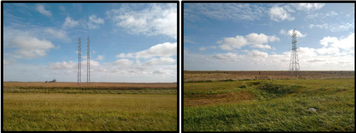
Figura 109 - Línea de media tensión, altura PR 29 (439+833).
