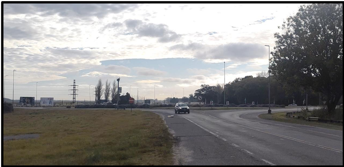
Figura 91 – Rotonda ingreso acceso a Villa Gesell. PR 0 (410+833)
