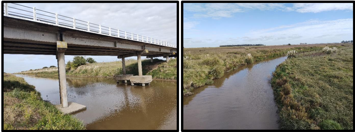
Figura 113 - Puente actual sobre Canal 5, PR 38+967 (449+800).
