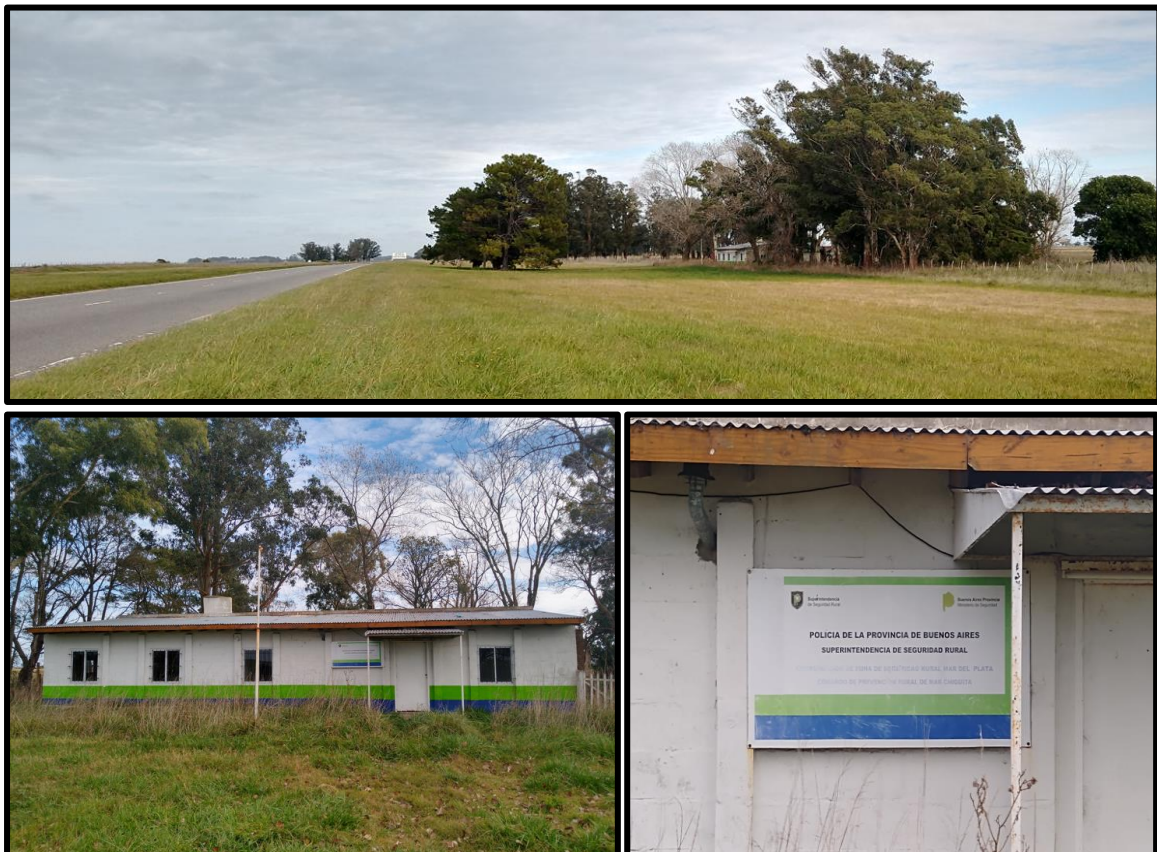
Figura 118 - Casilla Policía de la PBA, en estado de abandono, aproximadamente PR 1.
