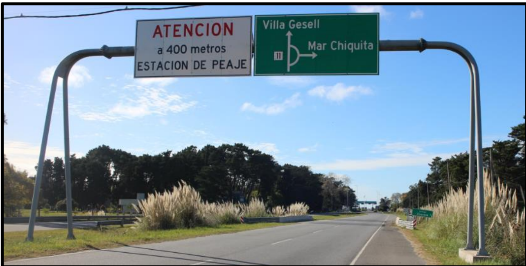
Figura 147 - Fin autovía actual RP11.
