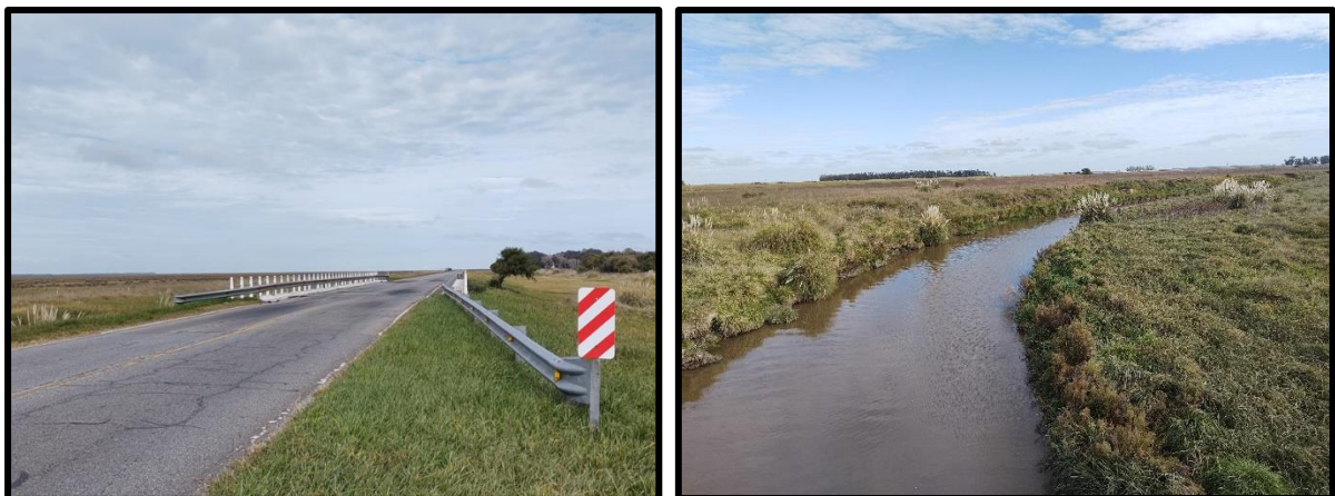
Figura 121 - Puente Arroyo Grande, PR 6+100.
