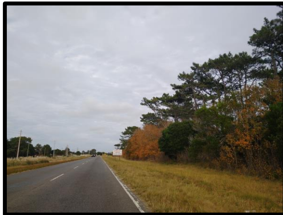
(Figura 97). Probablemente deberá ser removida parte de esta por encontrarse dentro de la AZC en zona de nueva calzada y cercana a la calzada existente.
