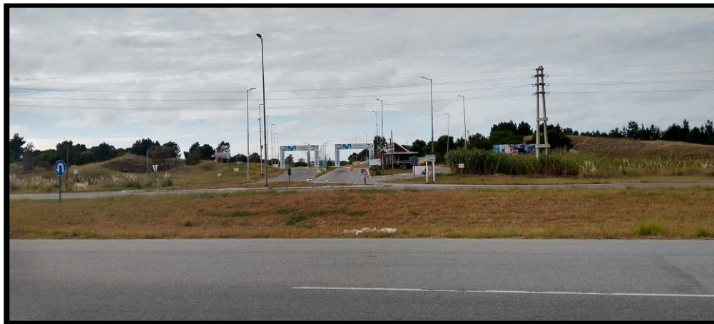
Figura 98 – Intersección entrada a Villa Gesell Sur, altura PR 5 (415+833).
